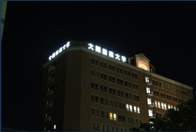
本館 北側・西側
